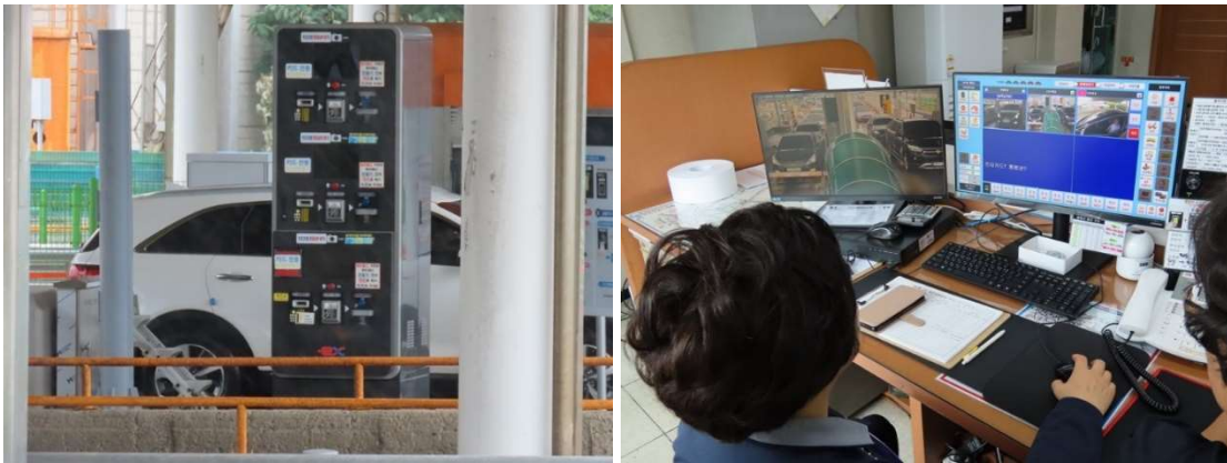
図 3-59 出口車線(左: 料金自動収受機(3 段)、右: 料金所事務所での遠隔サポート)
