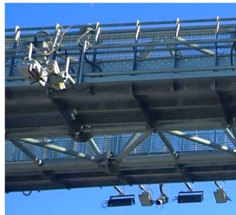
図 3-36 フリーフローETC の構成機器
