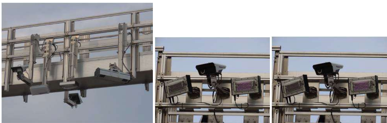
図3-45 個別車線の DSRC、センサ構成ナンバー読取りカメラ、車線全体撮影(軸数検知)カメラ
