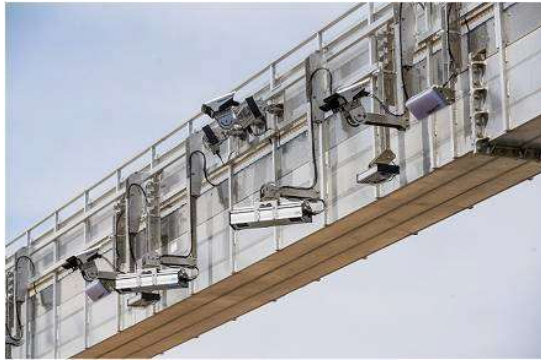
図3-38 ETCガントリーに設置された機器
